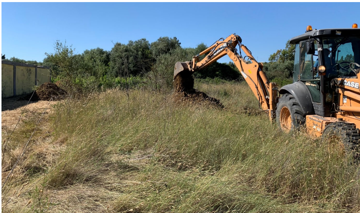
Fig.5: Posizionamento punto di sondaggio P3
