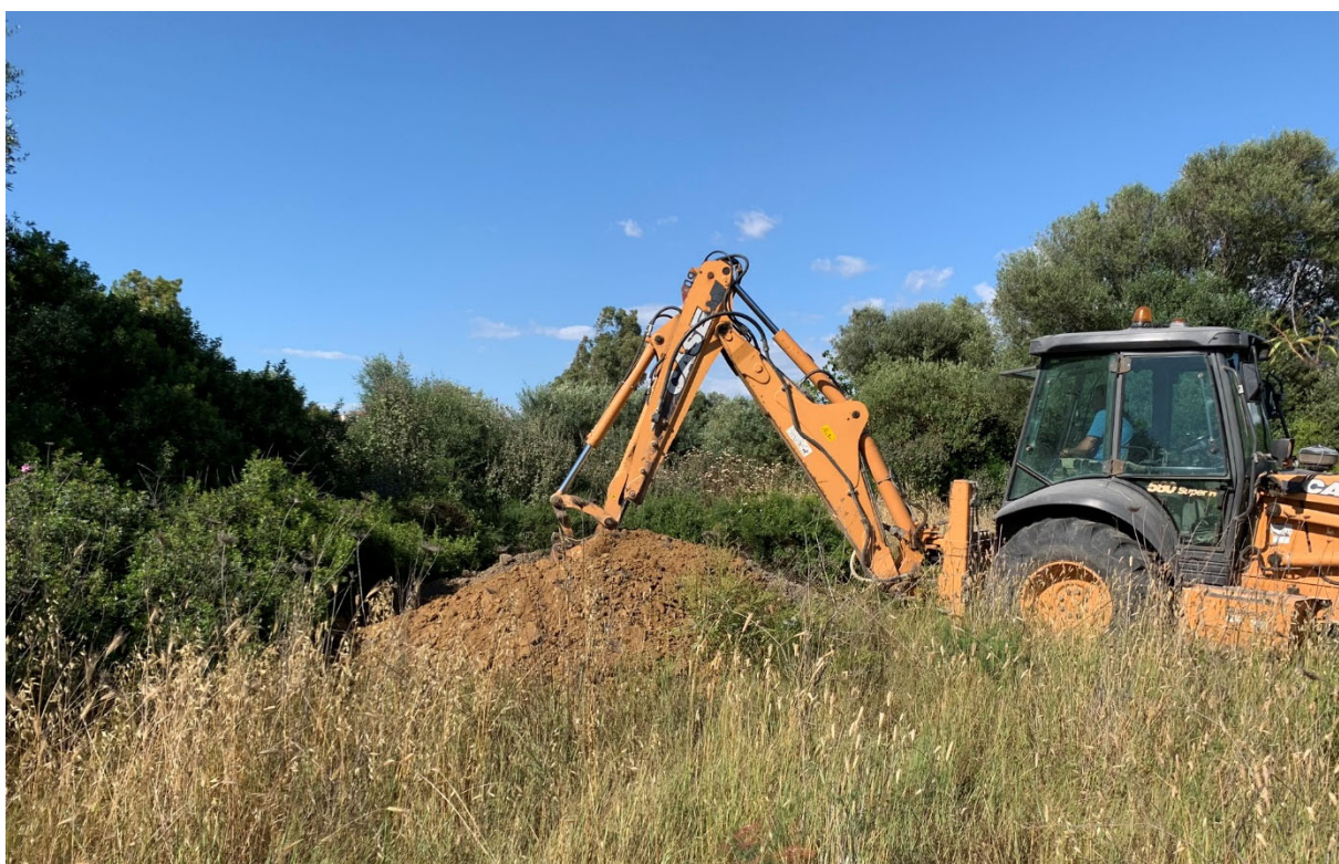
Fig.6: Posizionamento punto di sondaggio P4
