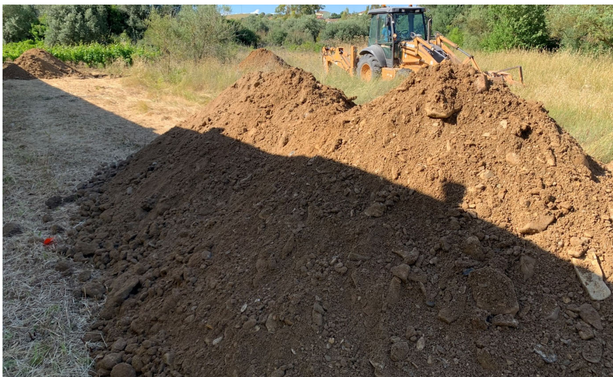
Fig.16: Ripresa fotografica del materiale estratto dal pozzetto geognostico P2
