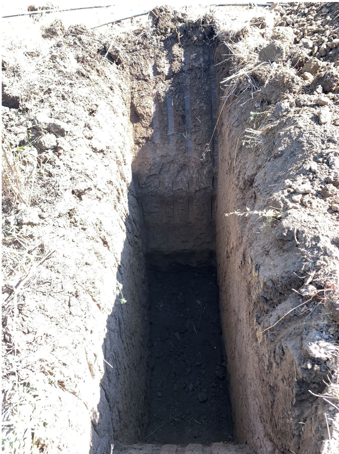
Fig.8: Ripresa fotografica pozzetto geonostico P1
