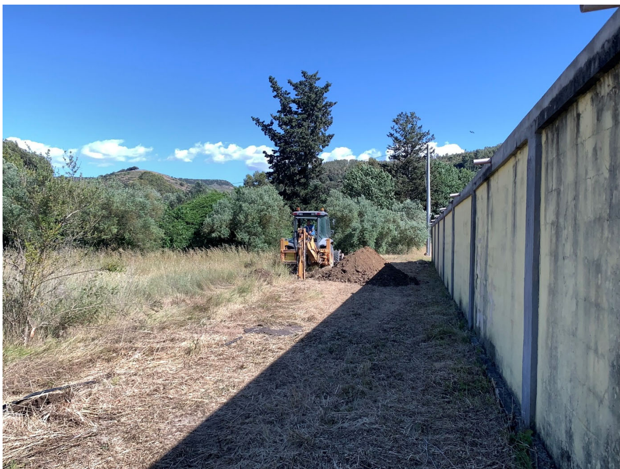
Fig.4: Posizionamento punto di sondaggio P2
