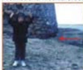
Dilavamento diffuso sul bordo della falesia, sui calcari arenacei alterati dell'unità stratigrafica più alta. A sinistra la nicchia erosiva sotto il basamento della torre, già ben incisa nel 1990
