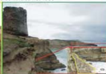
Dilavamento diffuso sul bordo della falesia, sui calcari arenacei alterati dell'unità stratigrafica più alta. A sinistra la nicchia erosiva sotto il basamento della torre, già ben incisa nel 1990
