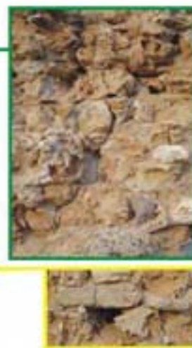
Nicchia erosiva alla base della torre per effetto della deflazione eolica, sempre molto attiva sul bordo delle falesie
