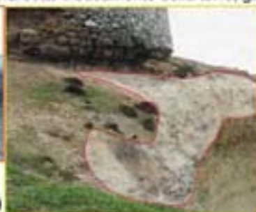
Dilavamento diffuso sul bordo della falesia, sui calcari arenacei alterati dell'unità stratigrafica più alta. A sinistra la nicchia erosiva sotto il basamento della torre, già ben incisa nel 1990
