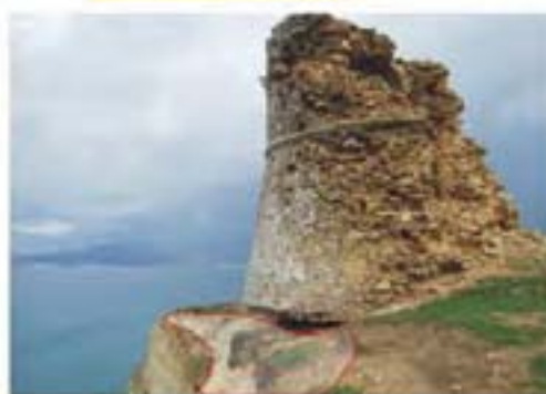
Dilavamento diffuso sul bordo della falesia, sui calcari arenacei alterati dell'unità stratigrafica più alta. A sinistra la nicchia erosiva sotto il basamento della torre, già ben incisa nel 1990
