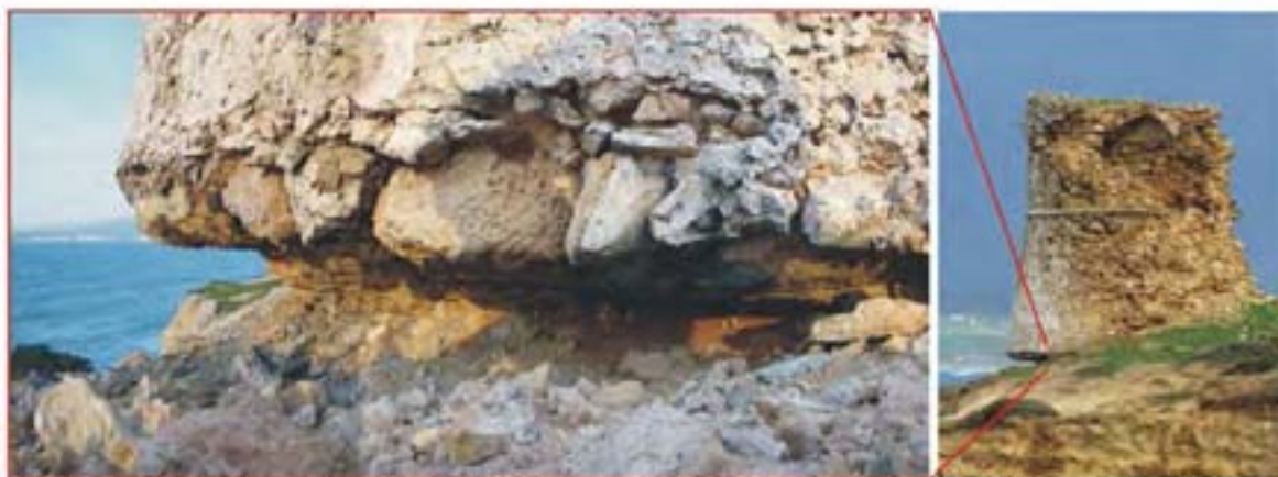
Nicchia erosiva alla base della torre per effetto della deflazione eolica, sempre molto attiva sul bordo delle falesie
