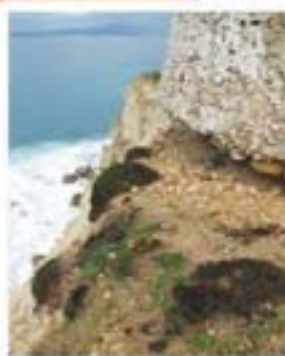
Dilavamento diffuso sul bordo della falesia, sui calcari arenacei alterati dell'unità stratigrafica più alta. A sinistra la nicchia erosiva sotto il basamento della torre, già ben incisa nel 1990
