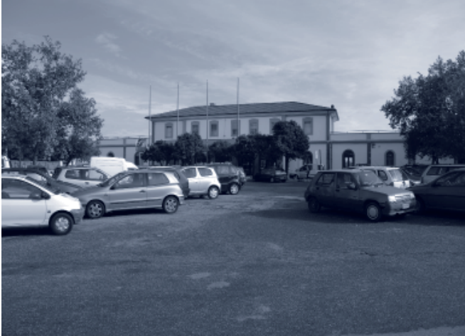
2_piazza-parcheggio davanti alla Stazione Ferroviaria (foto di Enzo Sanna)
