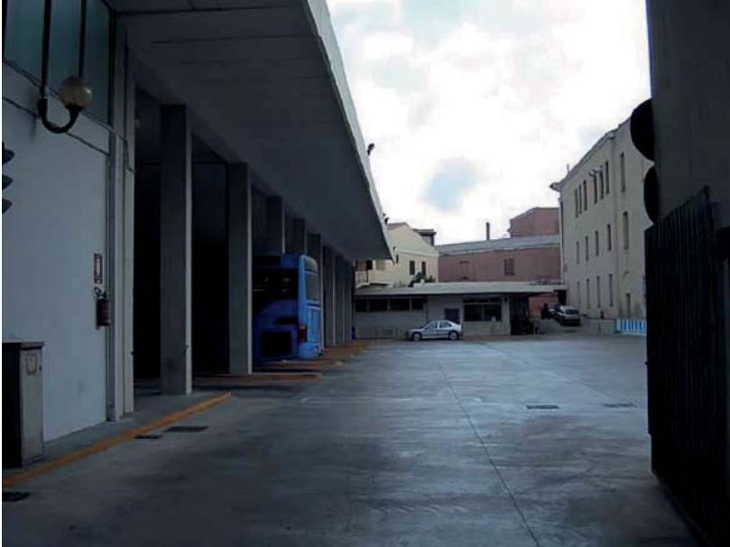
5_vista dell'interno dell'attuale stazione dei pulmann dell'ARST
